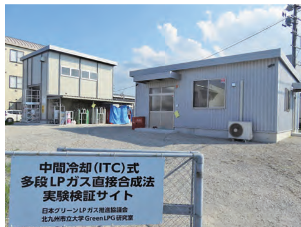
写真2 エコタウンプラント外観
