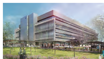
(3)徳島県N市庁舎
