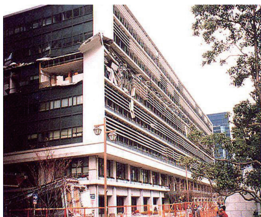
写真1 層崩壊(神戸市庁舎)
