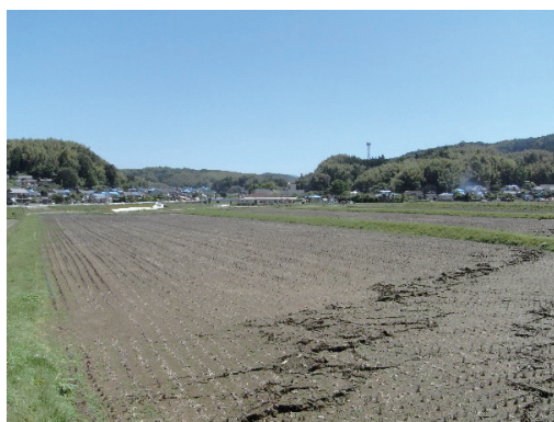
写真3 地割れとその向こうに見えるブルーシートがかけられた屋根(熊本地震)
