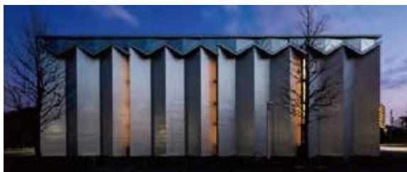
外壁は断熱材+耐久性の高いガルバリウム鋼板 写真:大森今日子
