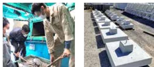
写真1 MFAS-PCa製造状況
