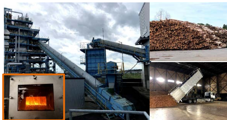
写真1 木質バイオマス発電所
