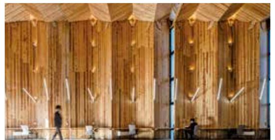
写真2 天井高8mの空間を僅か90mm厚のCLTを屏風状に配置して実現 写真：大森今日子
