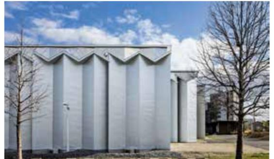
写真1 木版のCLTを屏風状に用いたメルディア高機能木材研究所（2020年1月竣工）写真：大森今日子
