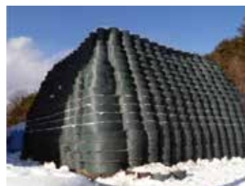
図5 多機能盛土(放射性物質含有汚泥隔離・保管)
