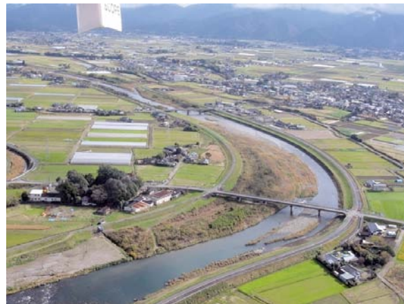
図4：防災用ハザードマップ用画像の撮影
