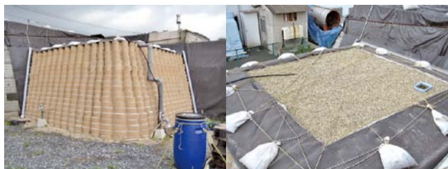
写真-1 「多機能盛土H型」の実証実験状況(左:全景, 右:天盤の豆砂利層)
