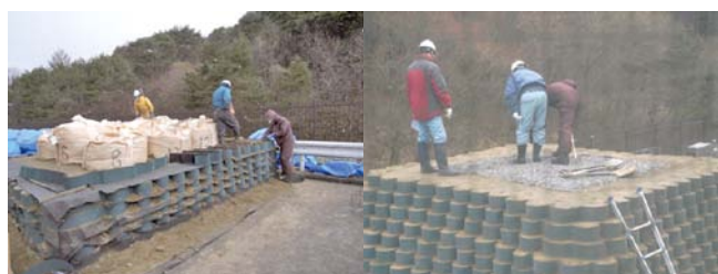
写真-3 「多機能盛土R型」の施工状況(左:フレコン設置後ジオセル施工, 右:天盤施工)
