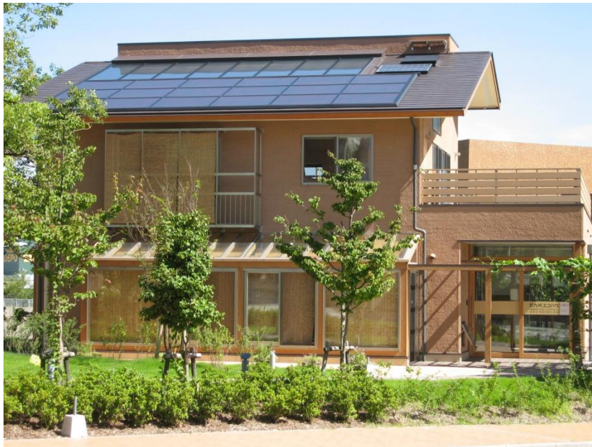
北九州エコハウスのパッシブ性能評価(北九州市)
